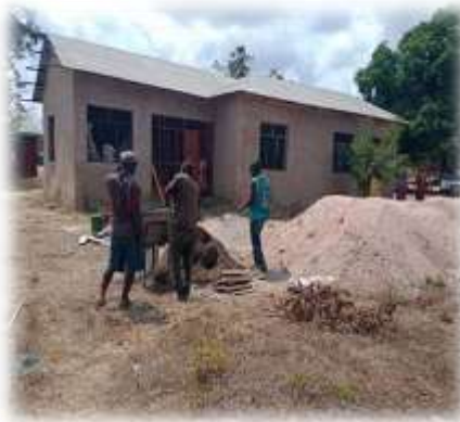
Hatua ya ujenzi wa Masjala ya Kijiji cha Mbondo Nachingwea
