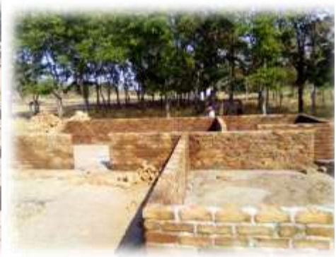
Hatua ya ujenzi wa masjala ya Kijiji cha Kapyo Mbarali
